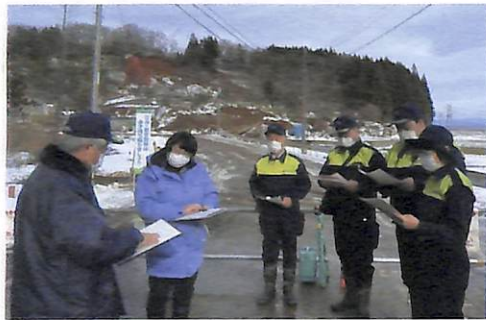
2023年末、西目地区土砂災害現場を視察 高橋ちづ子前衆院議員と
