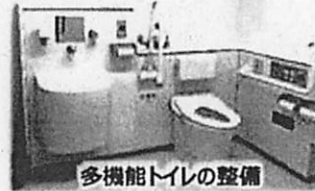
多機能トイレの整備
