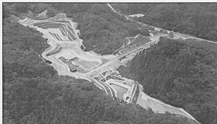
鶴岡市一般廃棄物最終処分場
